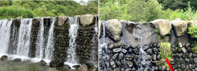
床固本体(中央部)の石材欠落状況
