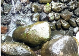
床固本体(中央部)の石材欠落状況
