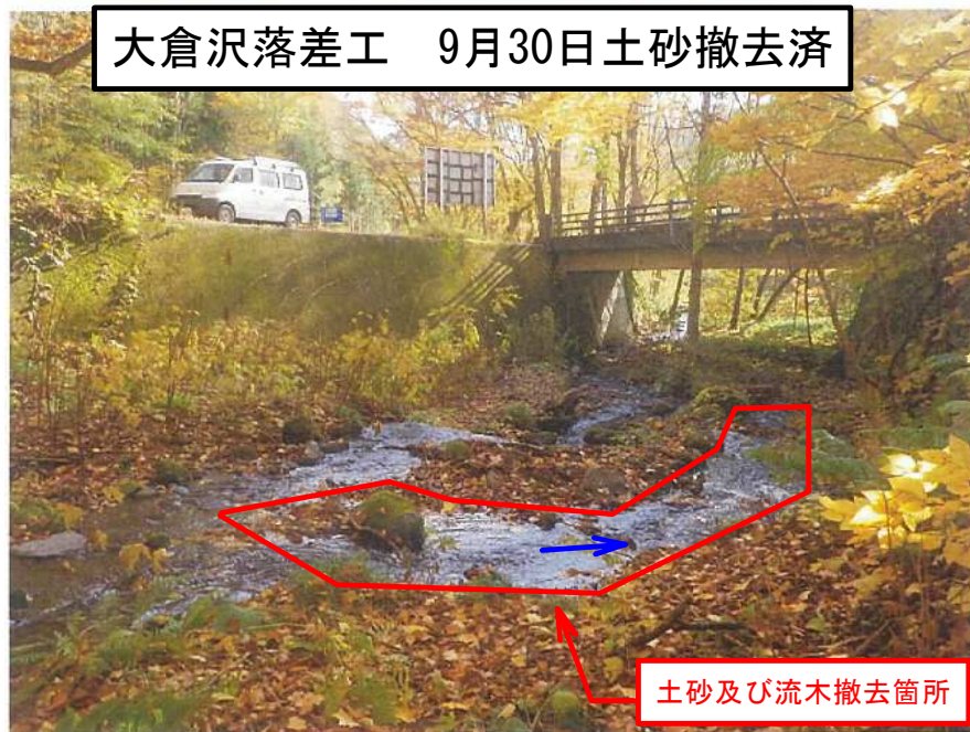
大倉沢落差工 9月30日土砂撤去済
