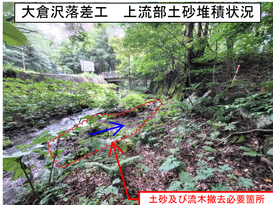
大倉沢落差工 上流部土砂堆積状況
