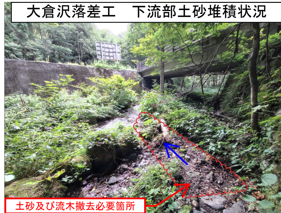
大倉沢落差工 下流部土砂堆積状況
