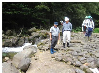
帯工14号の自然石張り工剥離
