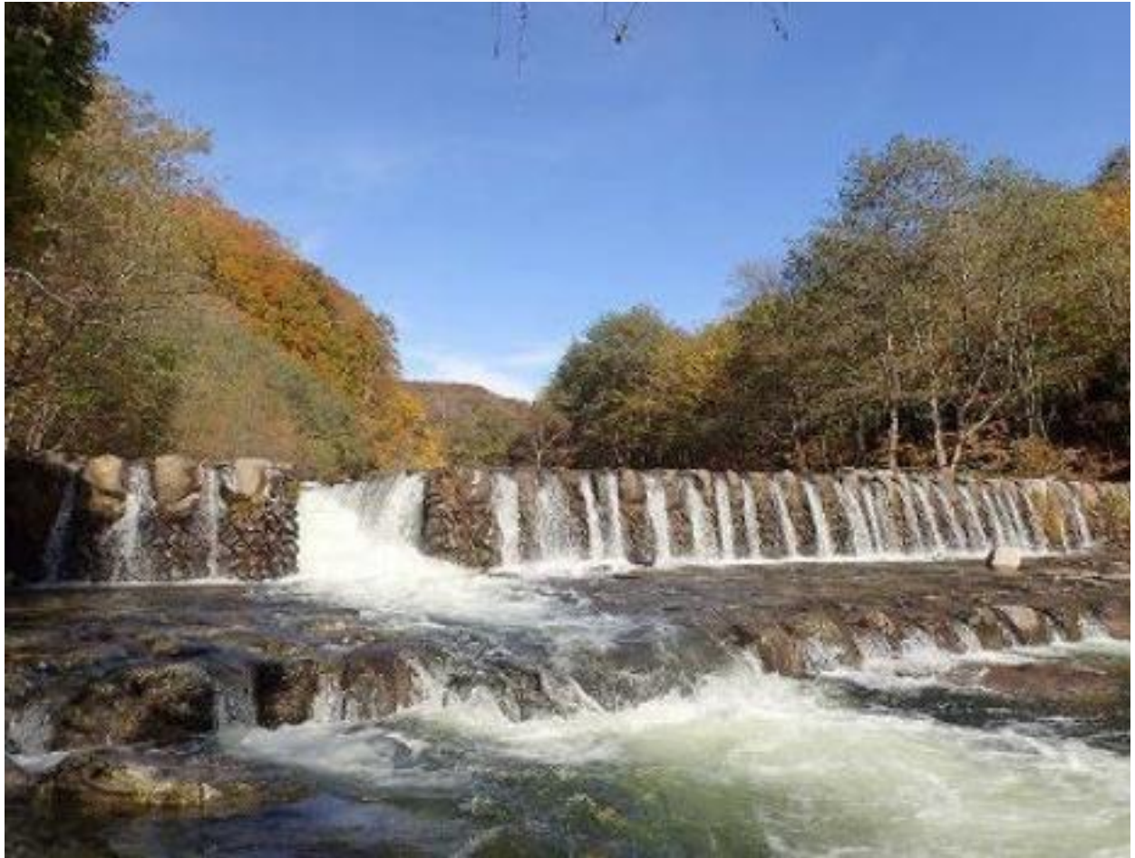
図1（5） 調査対象魚道部の状況 床固6号魚道 （図2（3）参照）
