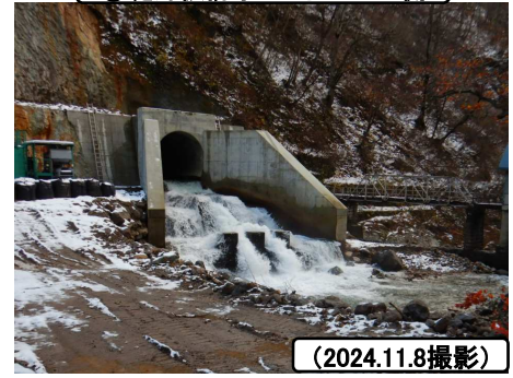
⑥堤外仮排水トンネル吐口側
