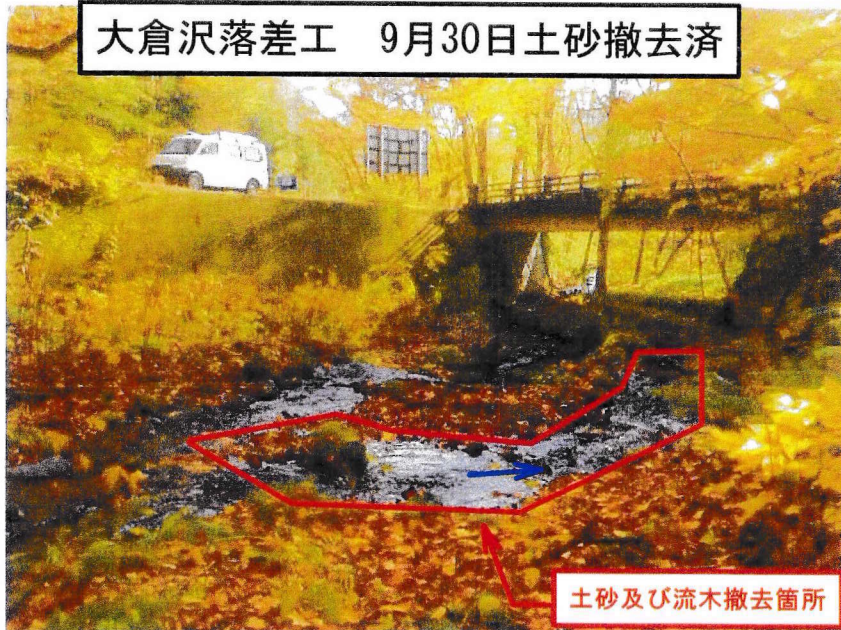
大倉沢落差工 9月30日土砂撤去済
