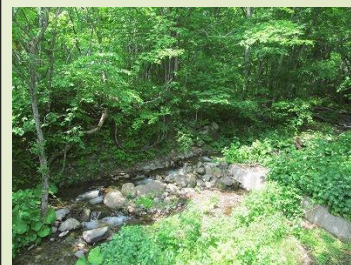
大倉沢落差工
