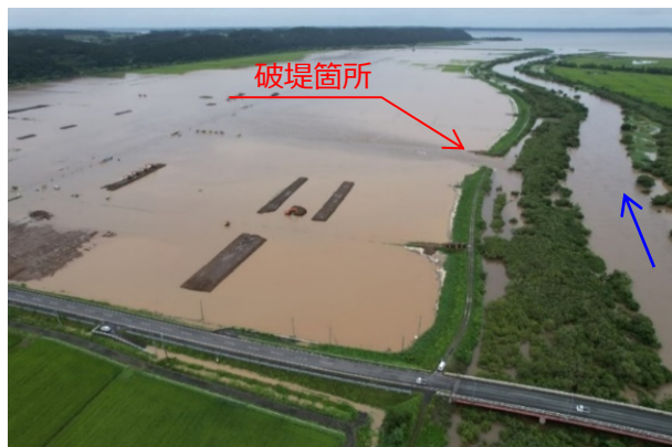
<写真>高瀬川堤防決壊箇所（七戸町川口）R3.8.10
