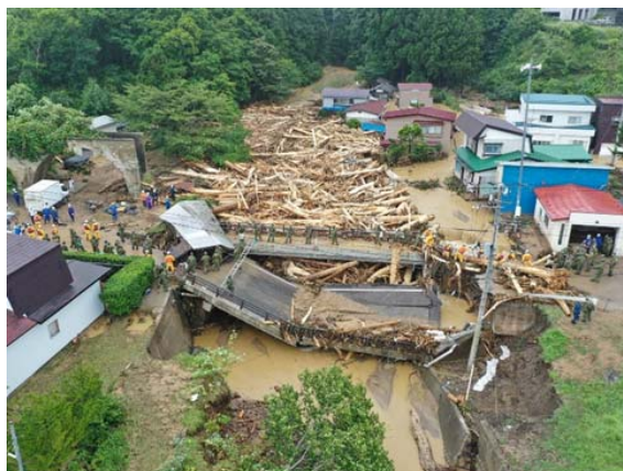
<写真>落橋した国道279号小赤川橋(むつ市大畑町) R3. 8. 11
