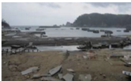
津波による防潮堤全面破壊 田老湾長内川河口全面海域
