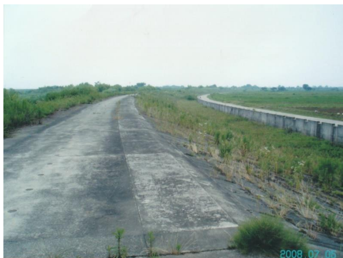
最上川水系大久保遊水地の越流堤防と背後地の利用状況
