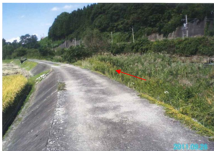
平川上流部の三面張堤防
