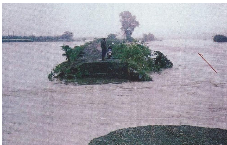
平成2年9月 虎渡地区の破堤状況(馬淵川治水史 p150)
