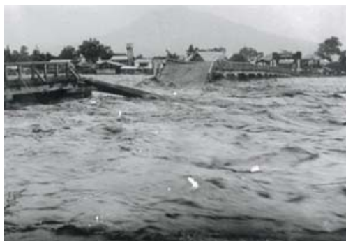
S33年8月11日岩木川洪水状況
