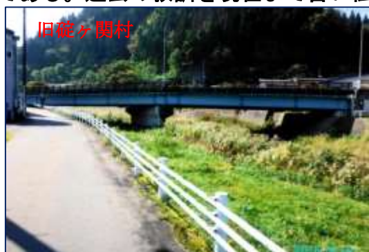
旧碓ヶ関村 国道橋(昭和 53 年 8 月竣工)
