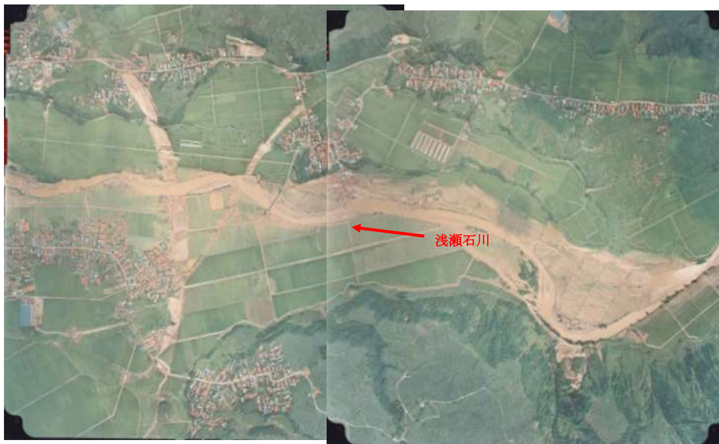
写真9 黒石市浅瀬石地区と石名坂地区の氾濫状況（河岸段丘下の家屋は流失全壊）
