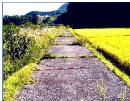
堤防の取り付け部(上流端)
