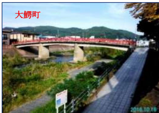
中の橋(昭和 40 年 3 月竣工)
