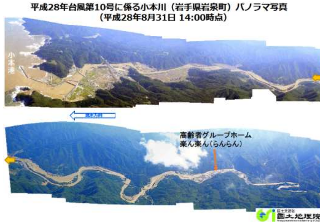
写真1 整備済み区間とその上流区域の氾濫状況（国土院撮影）
