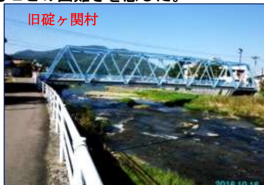
旧碓ヶ関村 朝霧橋(昭和 44 年 12 月竣工)
