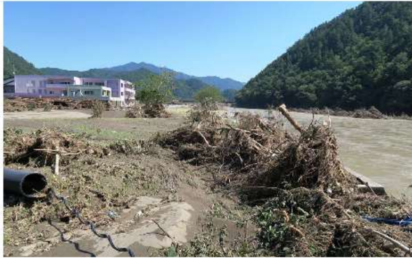
介護老人福祉施設はまるで河川敷に建っているように見える
