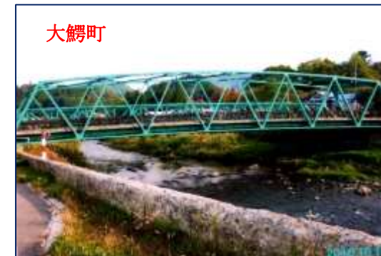
羽黒橋(昭和 59 年 12 月竣工)
