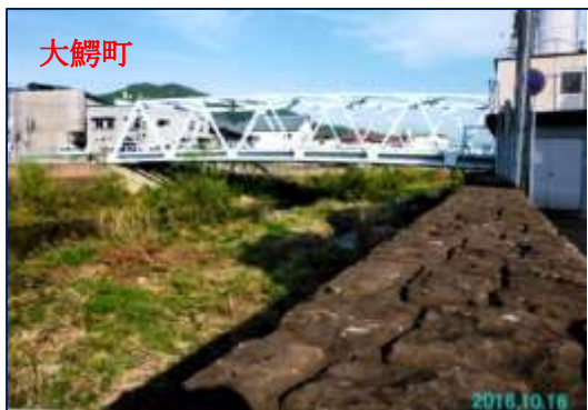
青柳橋(昭和 42 年 12 月竣工)
