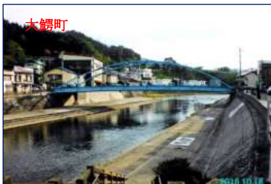
相生橋(昭和 40 年 3 月竣工)
