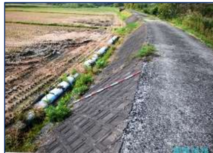
下流の三面張り堤防
