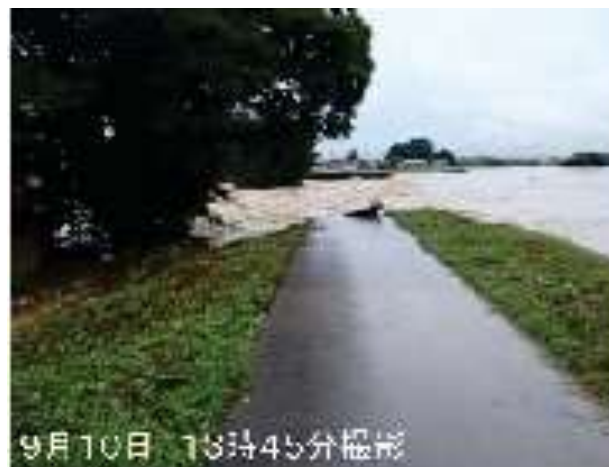
写真11 鬼怒川の破堤箇所付近の状況
