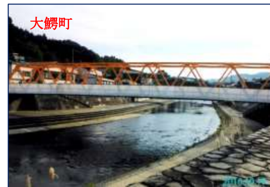
月見橋(昭和 43 年 3 月竣工)
