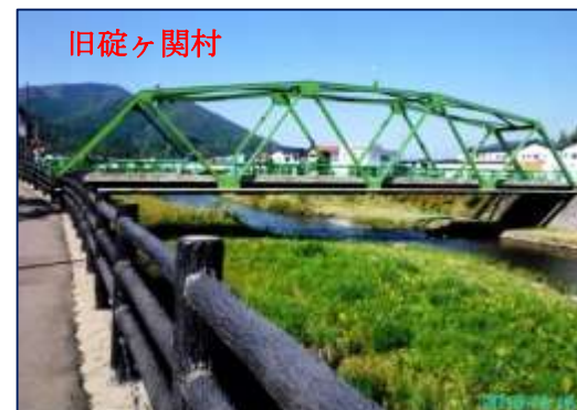
旧碓ヶ関村 三笠橋(昭和 42 年 12 月竣工)
