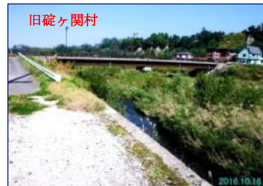
旧碓ヶ関村 かじか橋(平成 9 年 7 月竣工)
