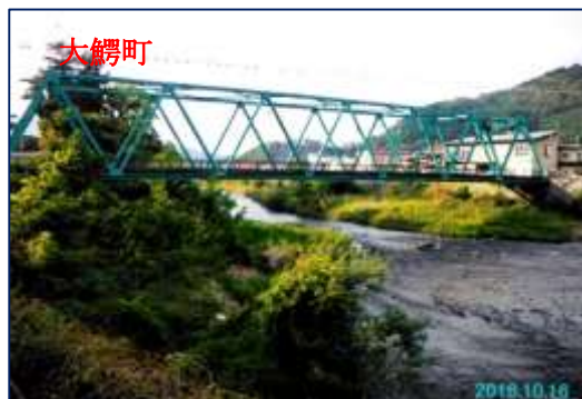
夏沢橋(昭和 45 年 12 月竣工)
