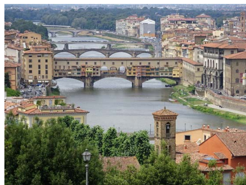
アルノ川（フィレンツェ市街）・ヴェッキオ橋
