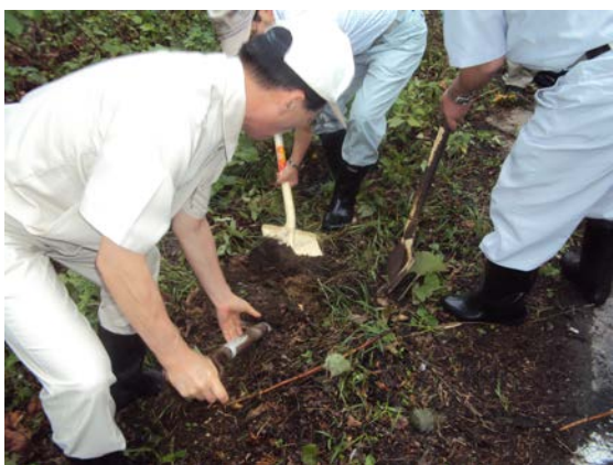
建立場所掘削
