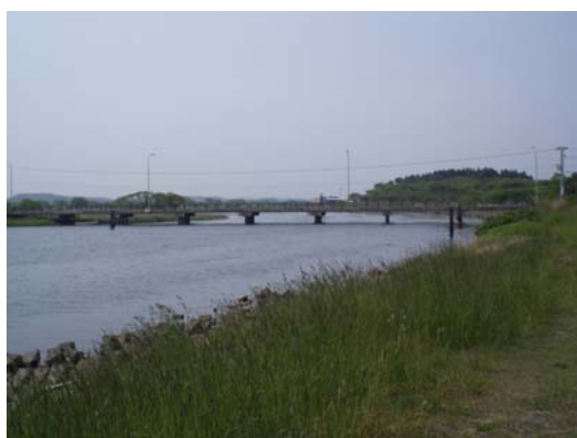
放水路分流地点から高瀬川下流を撮影（国道 338 号高瀬橋が見える）
